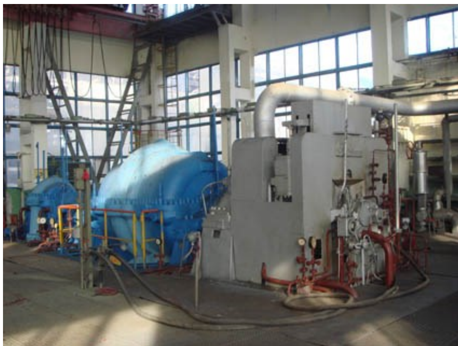
Рис.1 компрессор технологического воздуха поз.101J
